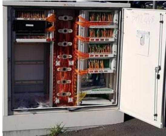
Quand on ouvre une armoire PM, on y trouve 2 parties : la partie gauche où arrivent les fibres de chaque opérateur et la partie droite d'où partent les fibres vers chaque PB où seront raccordés les clients.
